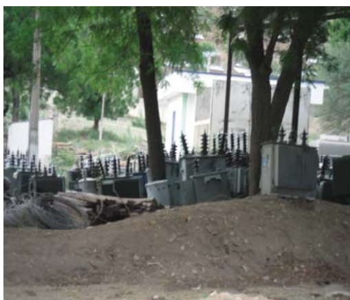
Photo n°12 : Stockage de transformateur à l'air libre dans l'Extrême Nord et sol contaminé au diélectrique
